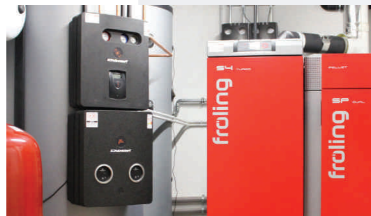
Pelletheizsystem mit Wärmespeicher
